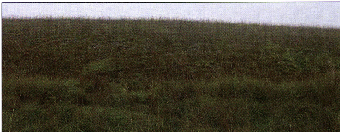
Abbildung 7: Ansicht der Deponieoberfläche im November 2011. Foto: STADT LAND FLUSS 09.11.2011.
