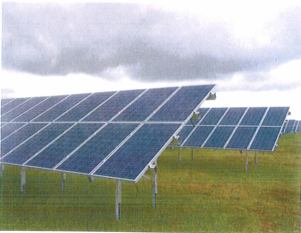
Abbildung 2: Detailansicht der zweireihigen Modultische
