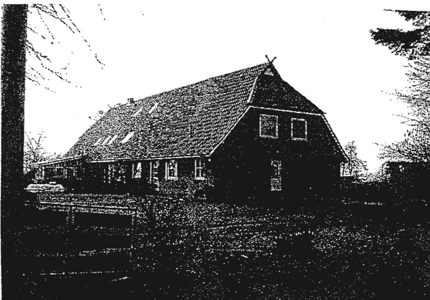
Umgebauter Scheunenteil – Holzverkleidung sind durch Putz ersetzt worden
