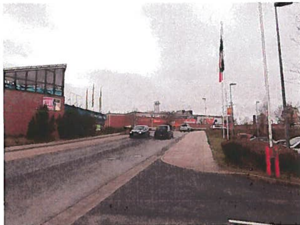
Blick auf das MEZ aus Richtung der Parkplatzzufahrt des Baumarktes.
