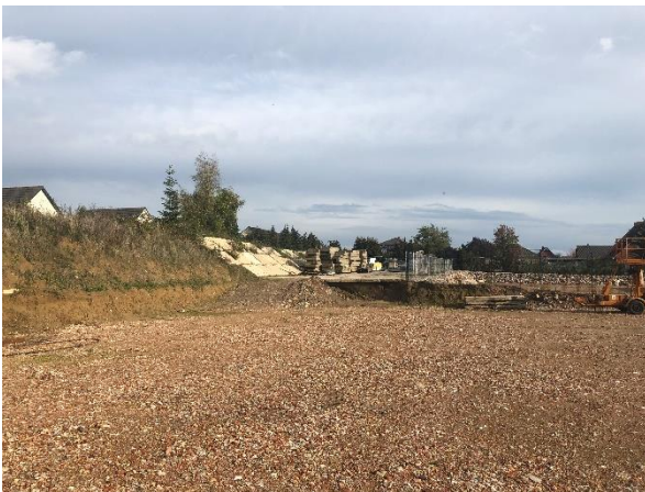
Vorgesehene Fläche für neue Lagerhalle
