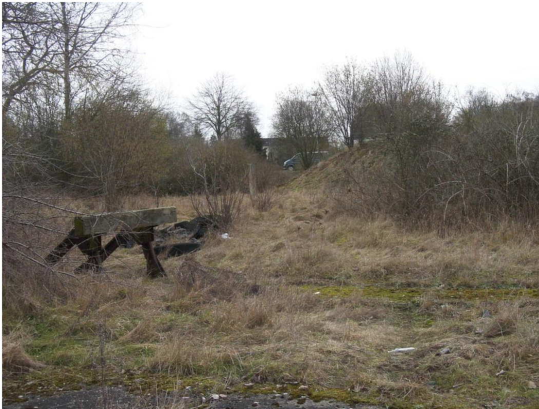
Bild 2.1 Das östliche Ende der alten Gleisanlage.
