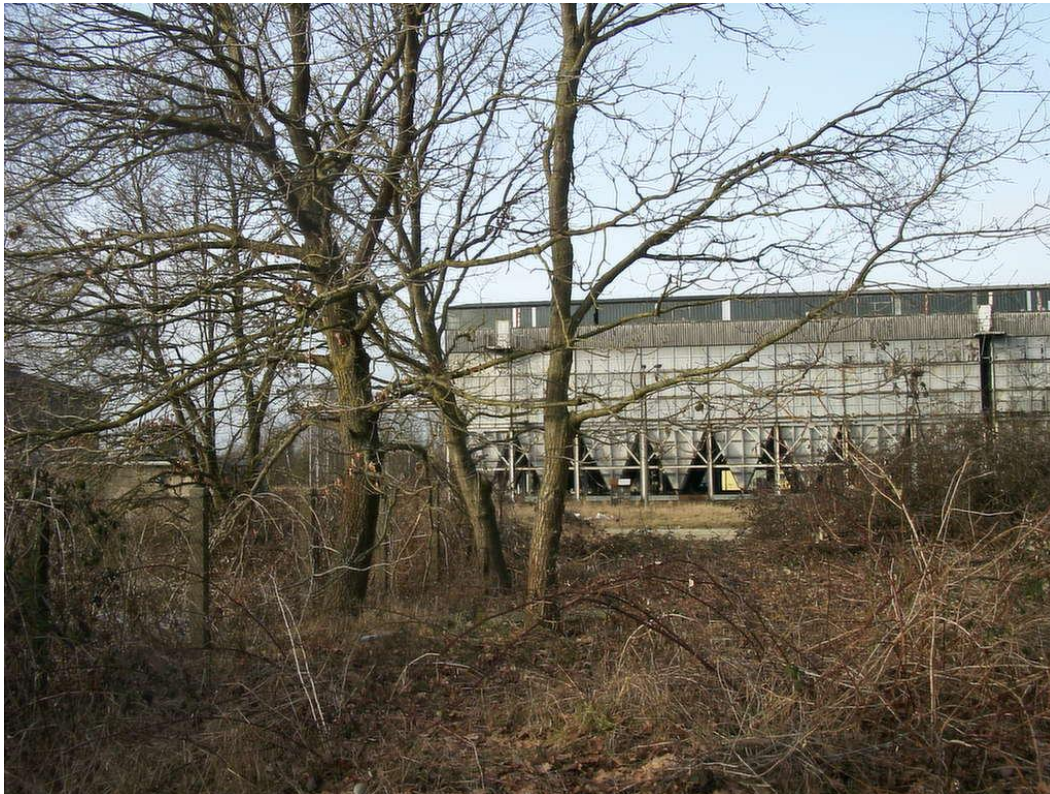
Bild 1.4 Blick nach Westen
