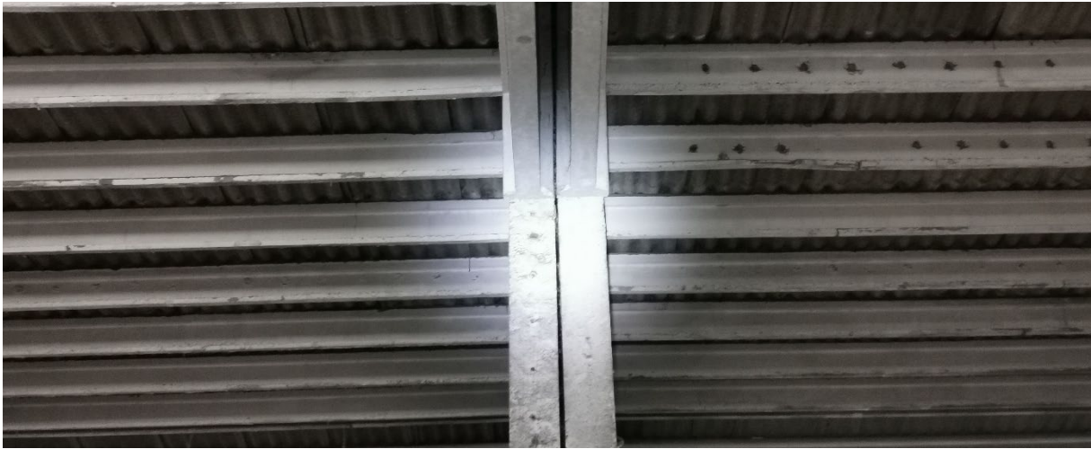
Abbildung 4: Stützpfiler und Träger in der Halle 5
