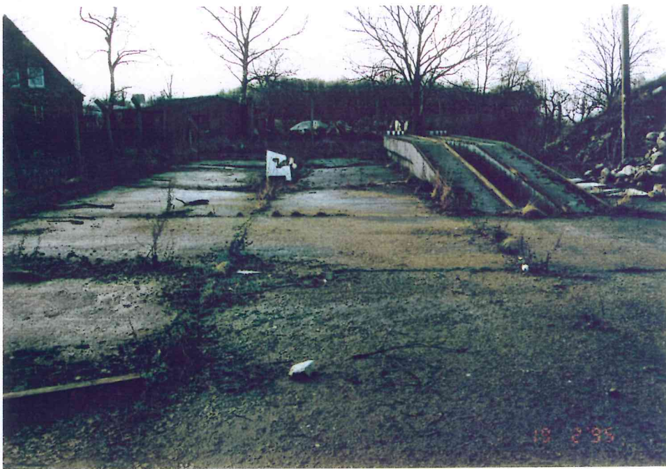
Abb. 12: Versiegelte Flächen, Rampe
