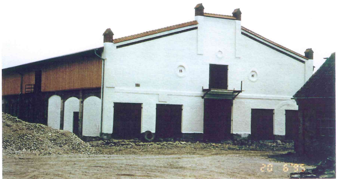
Das Gutshaus und diese renovierte Scheune stammen aus den letzten Jahren des 19. Jahrhunderts.
